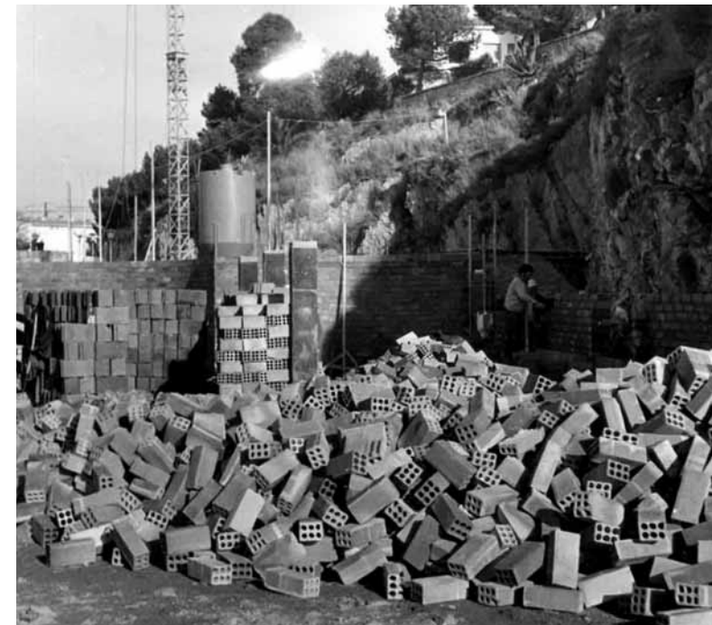
Construcció del primer edifici del Club a la muntanya del Fortim, inicis c. 1972. Arxiu personal Jaume Micó
