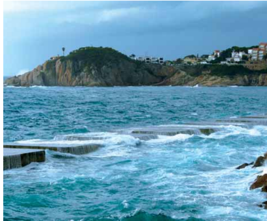
Remullada dels blocs de ciment de l'escullera, novembre de 2008. Arxiu CNSFG. Autor: Quito Pi
