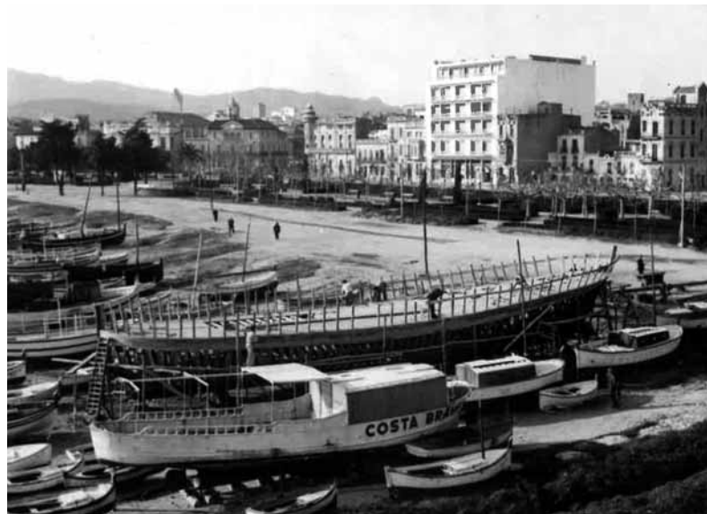
Vista de la platja de Sant Feliu amb les drassanes de Ramon Gay, durant la construcció d'un creuer turístic, 6 de febrer de 1958. Arxiu personal Jaume Micó
