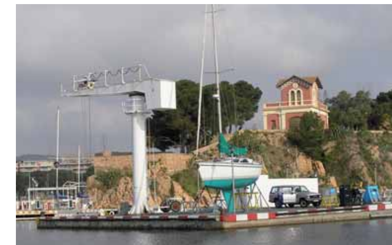
La zona del martell amb la grua de la Generalitat i la benzinera dels pescadors on s'estudiava instal·lar la nova benzinera del Club Nàutic, 2009. Arxiu CNSFG
