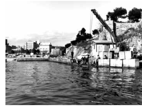
Construcció de les obres dels molls al Fortim, c. 1970. Arxiu CNSFG. Autor: Narcís Sans
