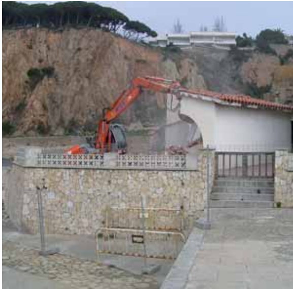
Enderrocamment de l'antiga "caseta del gruista", 20 de març de 2006. Arxiu CNSFG. Autor: Quito Pi
