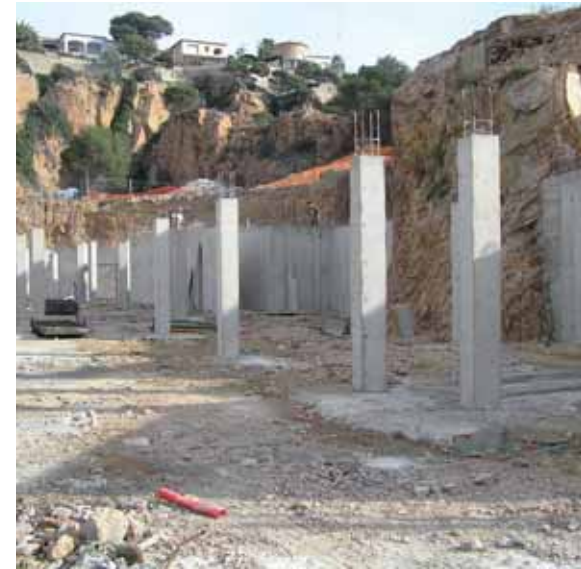
Els pilars de l'edifici ja estaven construïts el 4 de desembre de 2006. Arxiu CNSFG. Autor: Quito Pi
