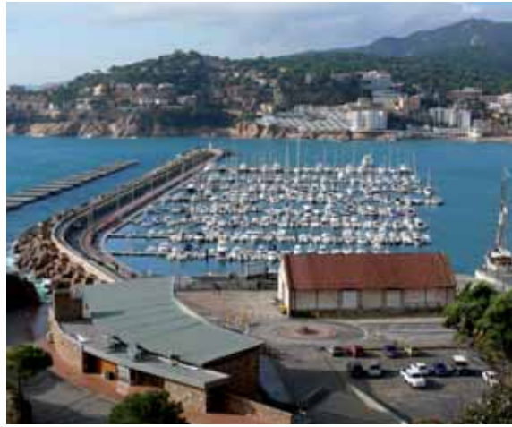
Les noves instal·lacions amb la dàrsena i seu social, 30 de desembre de 2008. Arxiu CNSFG. Autor: Quito Pi
