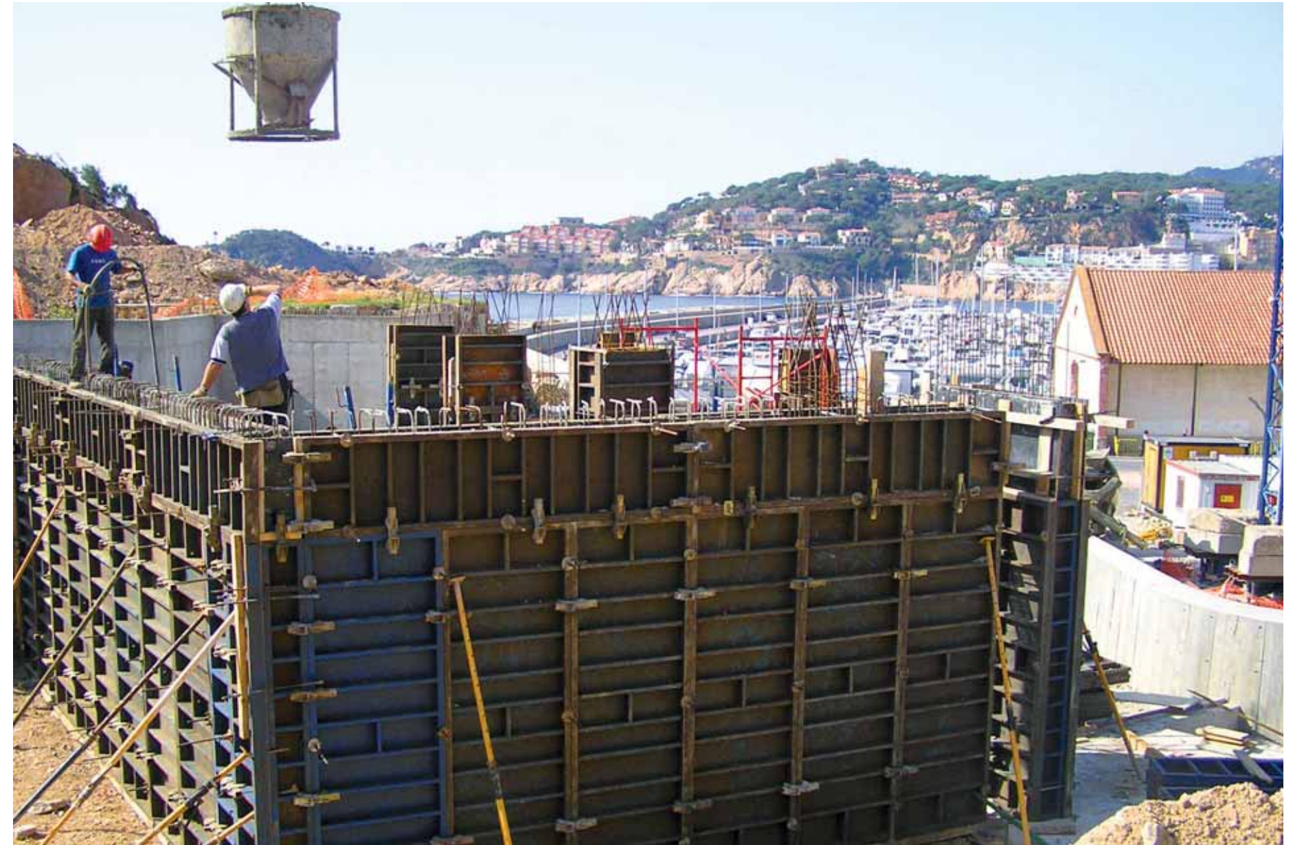
L'encofrat dels murs de l'edifici el 13 de març de 2007. Arxiu CNSFG. Autor: Quito Pi
